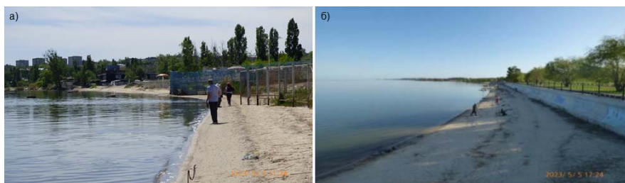
Рисунок 4. Примеры мягкой берегозащиты в виде искусственных пляжей: а) пляж «Солнечный» (Пушкинская набережная), б) Чеховская набережная, г. Таганрог
